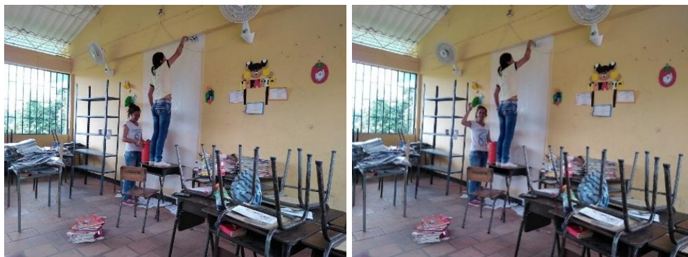
Figura 17. Organización y adecuación del espacio para ubicar el estante que contiene el CRA de Matemáticas para el grado tercero
